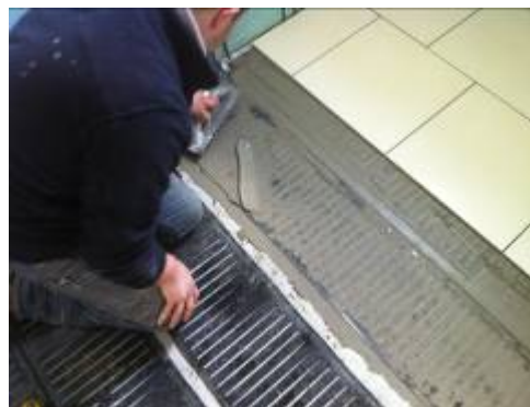
Figure 3 – Marouflage des éléments chauffants
